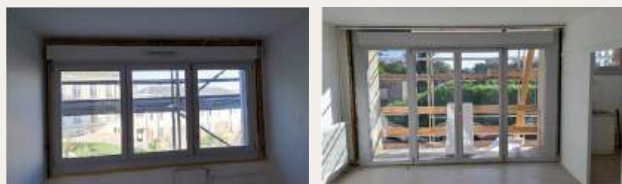
Remplacement de l'ensemble des blocs fenêtres et motorisation des volets roulants des baies vitrées pour faciliter leur usage.
