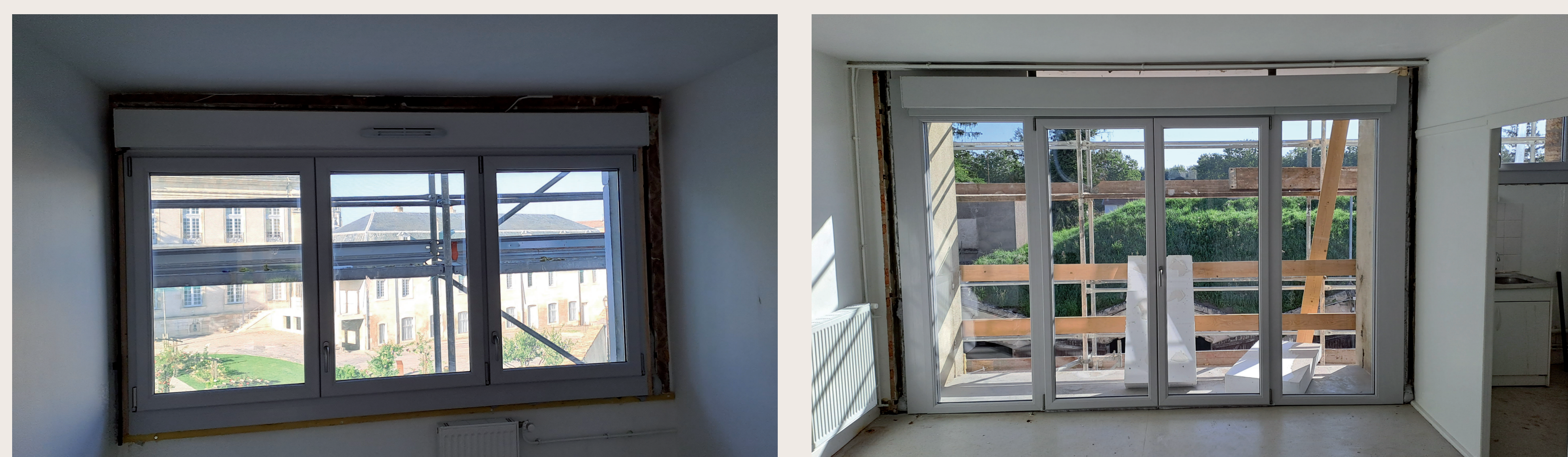
Remplacement de l'ensemble des blocs fenêtres et motorisation des volets roulants des baies vitrées pour faciliter leur usage.
