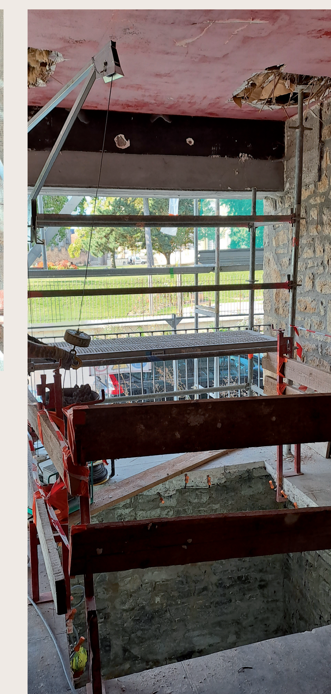
Le désamiantage a mis à nu les logements pour une redistribution complète.
