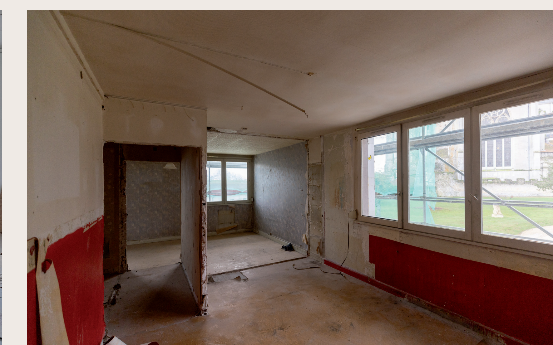
Le désamiantage a mis à nu les logements pour une redistribution complète.
