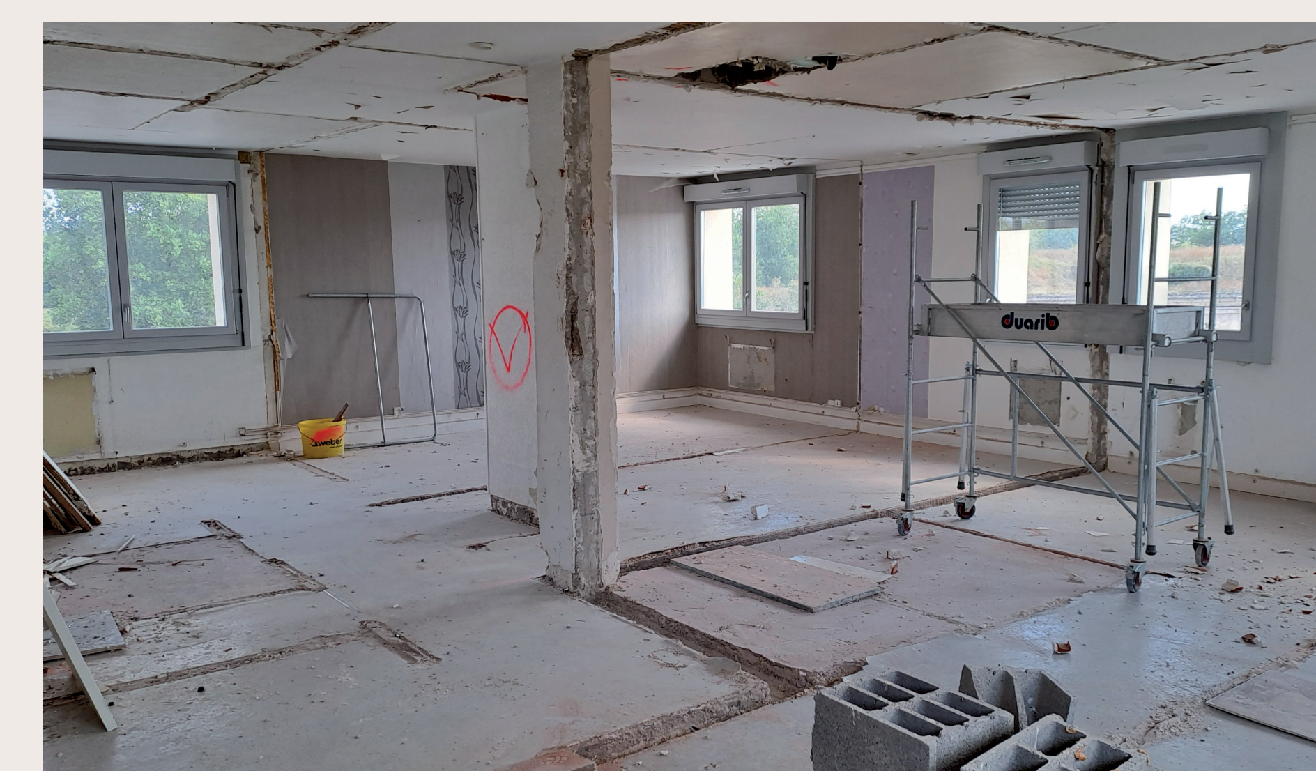
Le désamiantage a mis à nu les logements pour une redistribution complète.
